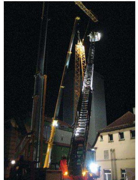
Aus dem Korb der Drehleiter wurde zuerst das Seil des Autokrans an den abgestürzten Teilen befestigt, bevor dann die restlichen Verbindungen zum Kran gekappt wurden.
