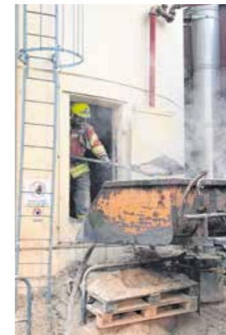
In mühsamer Handarbeit mussten die Wehrkräfte die Späne aus einem Silo herausschauflern. Zuvor löschten sie an der defekten Förderschnecke ein Glutnest. Foto: privat
