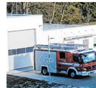
Die Technik des 2017 errichteten Magazins soll 2020 erneuert werden. Foto: privat
