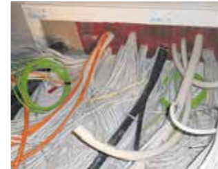
Kabelschott
